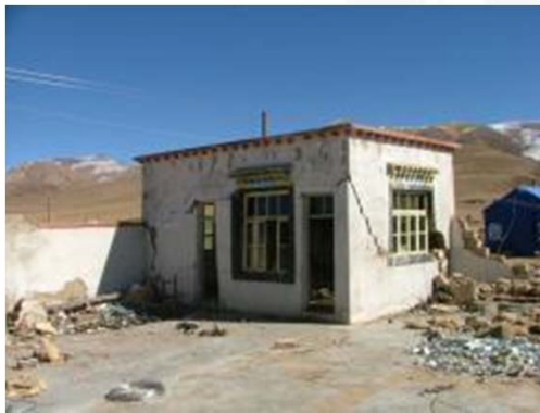
过窄的门窗间墙易在地震中首先破坏
