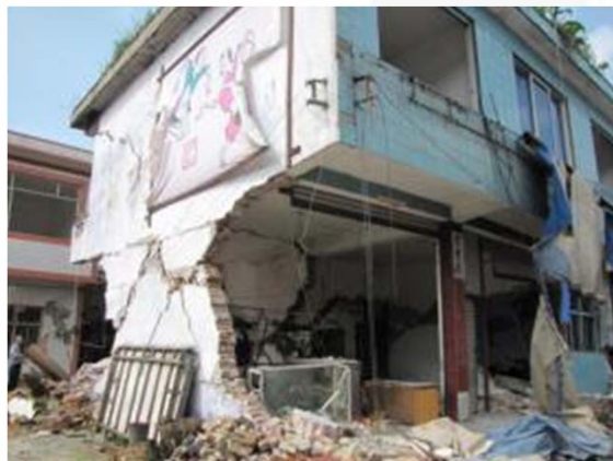
芦山地震九度区砖混房屋严重破坏至局部倒塌—— 无有效抗震构造措施，砂浆强度低
