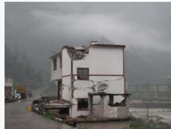
芦山地震九度区砖混房屋严重破坏至局部倒塌—— 无有效抗震构造措施，砂浆强度低
