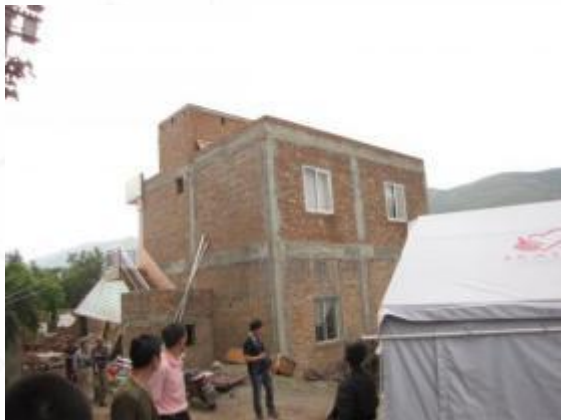
鲁甸地震九度区砖混房屋基本完好— 构造措施完备，砂浆强度高
