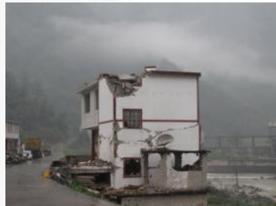
芦山地震砖混房屋严重破坏至局部倒塌— 无有效抗震构造措施，砂浆强度低
