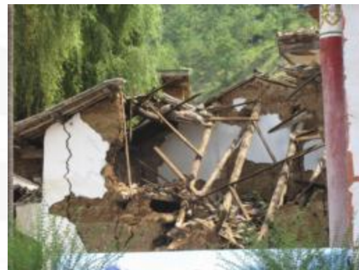
鲁甸地震（9度区） 生土房屋破坏情况
