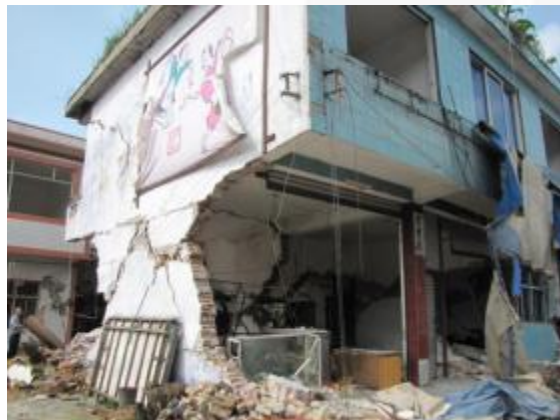
芦山地震砖混房屋严重破坏至局部倒塌— 无有效抗震构造措施，砂浆强度低
