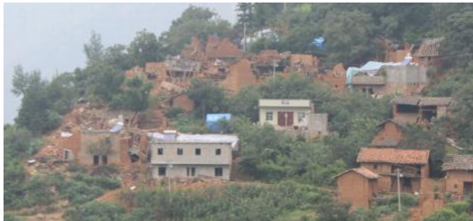
鲁甸县火德红镇李家山村（8度区） 生土房屋破坏情况
