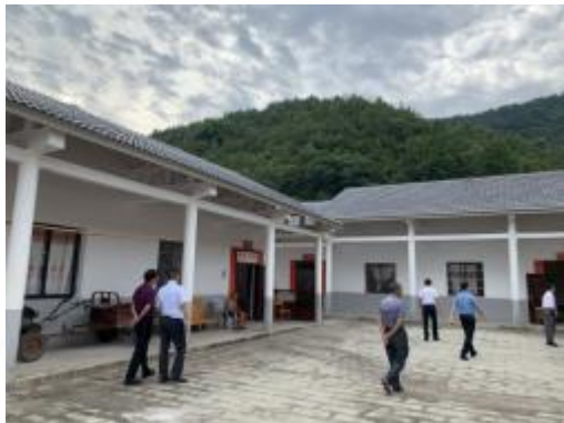
统规统建 易地扶贫搬迁 安置房屋
