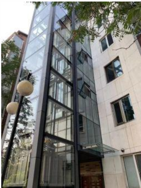
加建室外电梯
