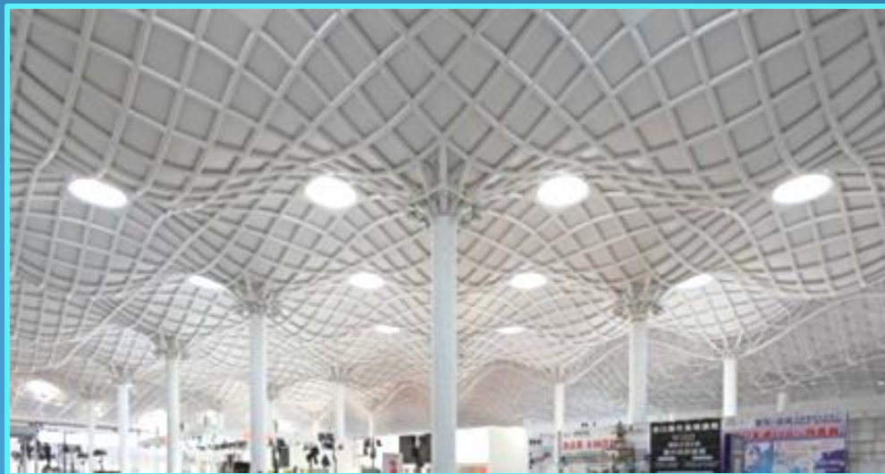
投入使用的展览中心大厅
